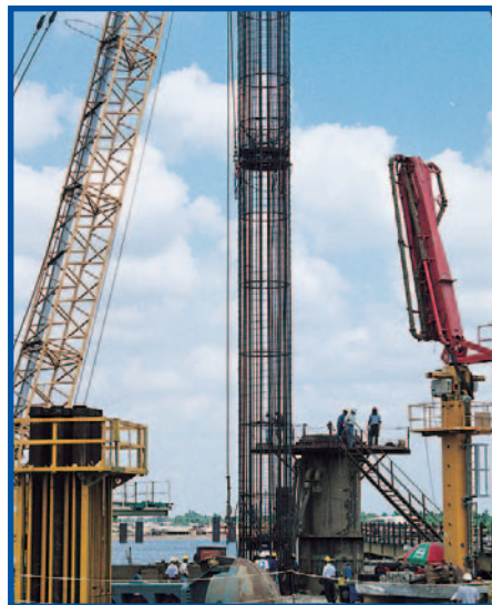
15-450피트의 시험 말뚝(현장타설)을 성공적으로 설치했습니다. 길이가 130피트인 기성 콘크리트 말뚝을 타입하고 O-cell을 사용하여 시험을 완료했습니다.
