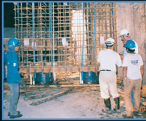
O-cell을 슬러리가 충전된 바레트에 설치
