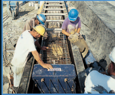
O-cell을 기성 콘크리트 말뚝에 설치
